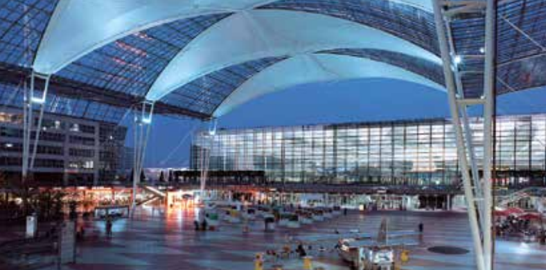
Комплекс аэропорта Мюнхена (МАС)
